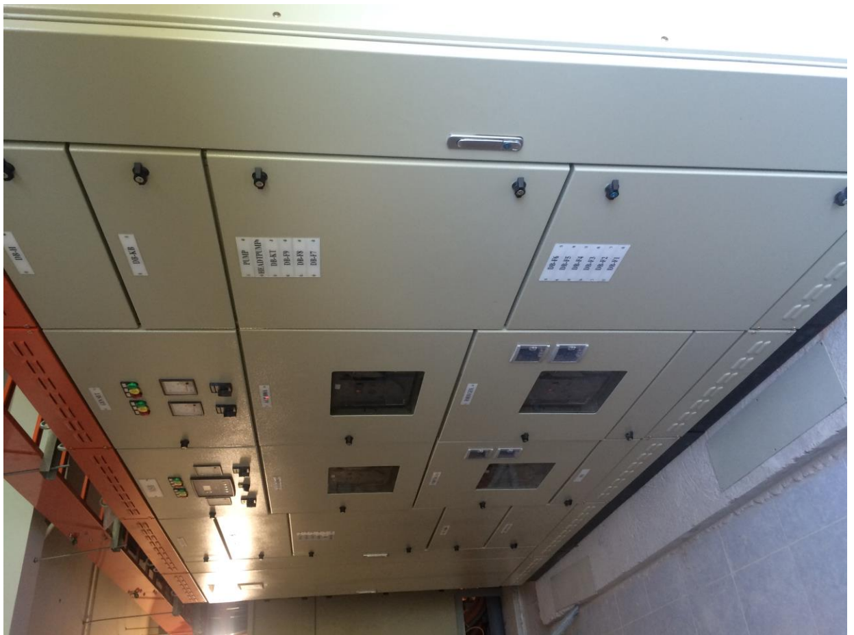
Lắp đặt đầu nối tủ tổng MSB.
